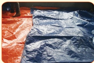
Đậy kín toàn bộ bề mặt bằng bạt
